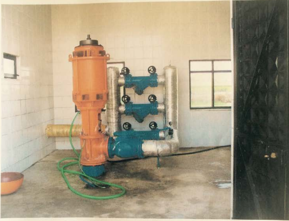
Şekil 4. Jeotermal Kuyu ve Kuyu Başı Pompa
